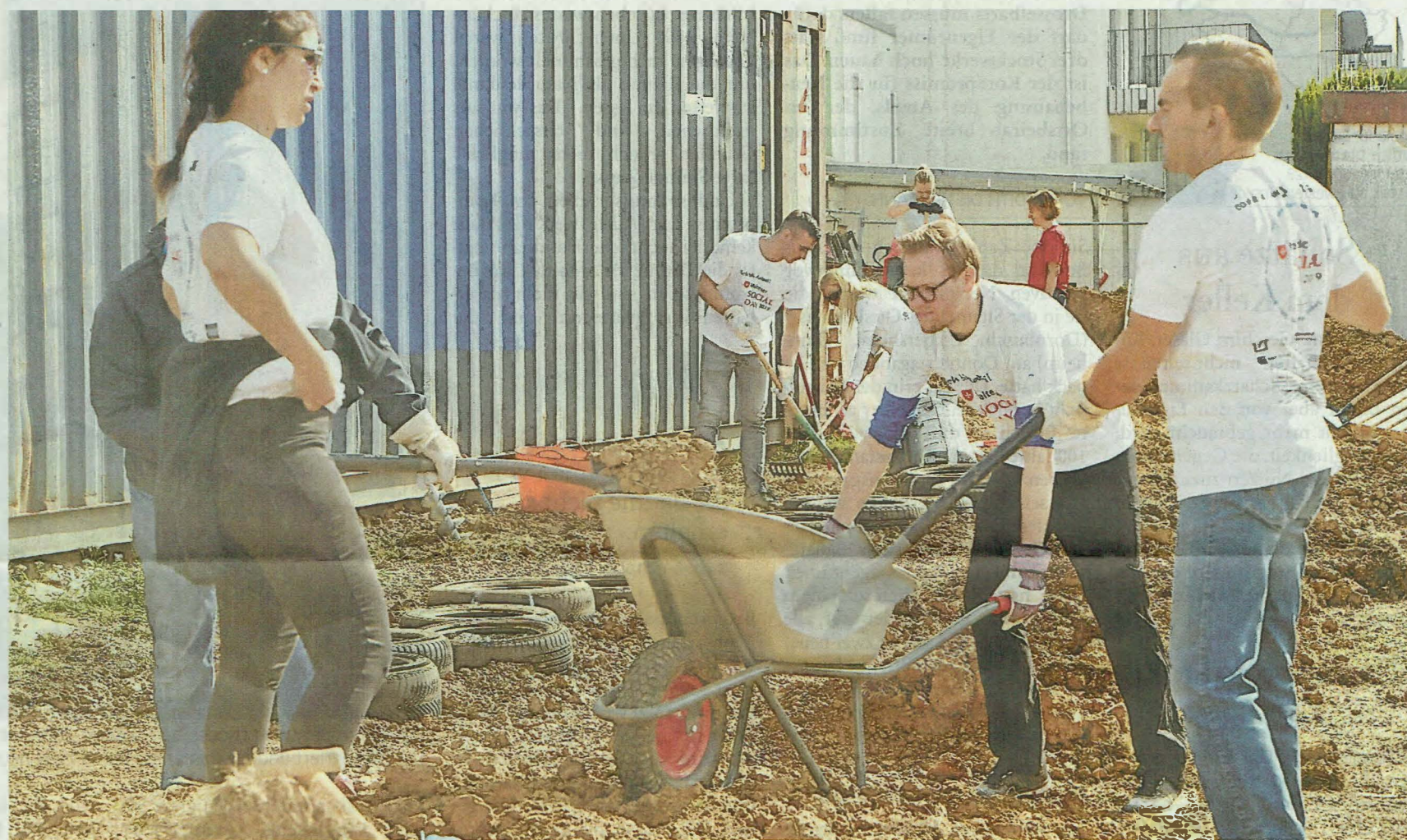
Hier entsteht an der Alten Turnhalle Kalbach ein Barfußpfad. 15 Mitarbeiter von Lazard Asset Management helfen an diesem Tag beim Bau. Foto: Rainer Ruffer
